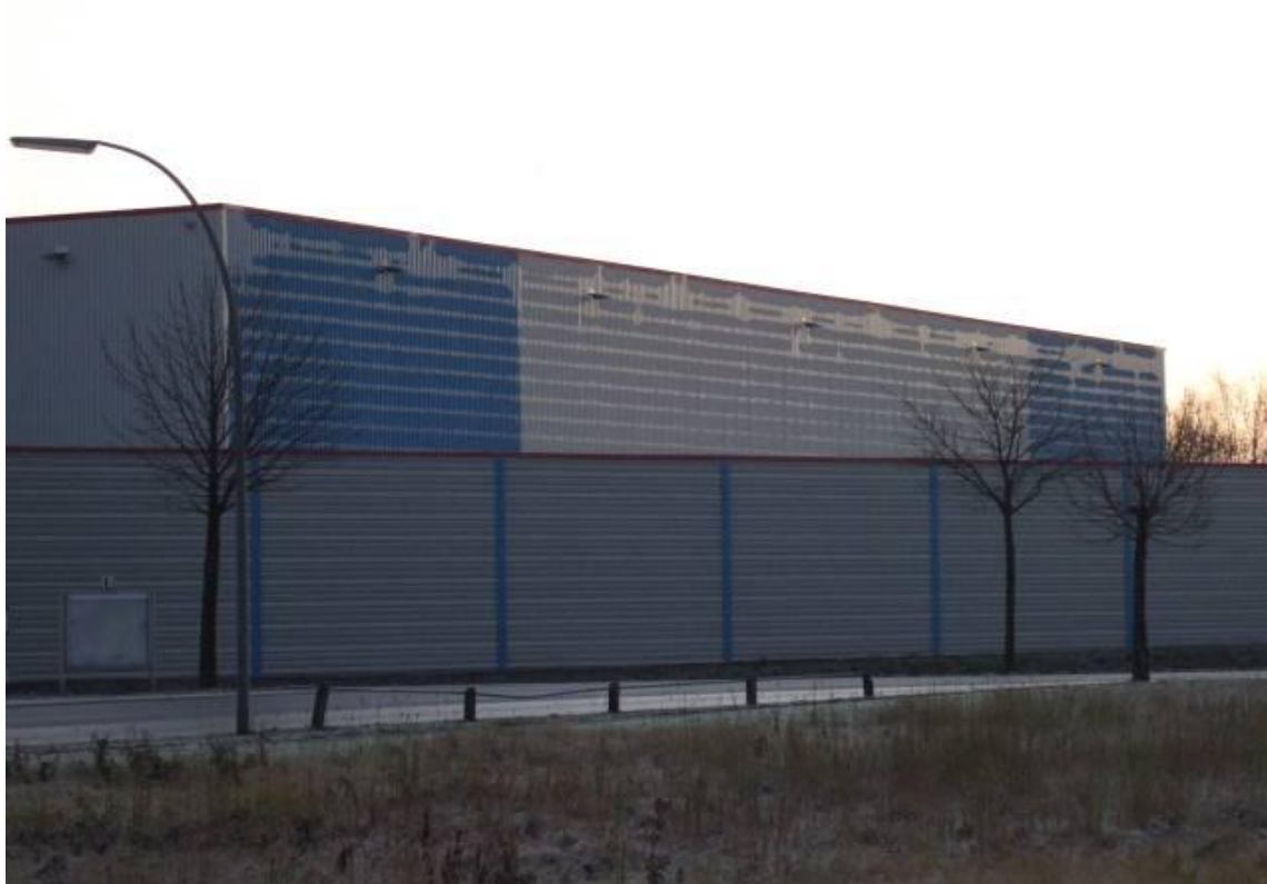
Industriefassade: Wärmebrückenwirkung der Kassettenflansche
