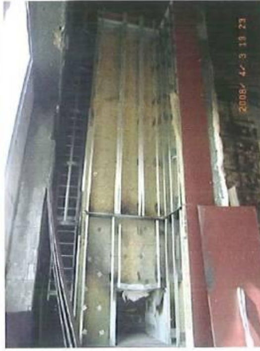
Abb. 10: Zustand des Prüfaufbaus - Eternit entfernt
