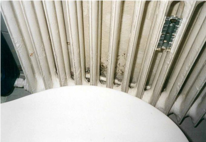
**Abb. 4:** Schimmelpilz unmittelbar hinter einem – offensichtlich nicht betriebenen – Heizkörper
