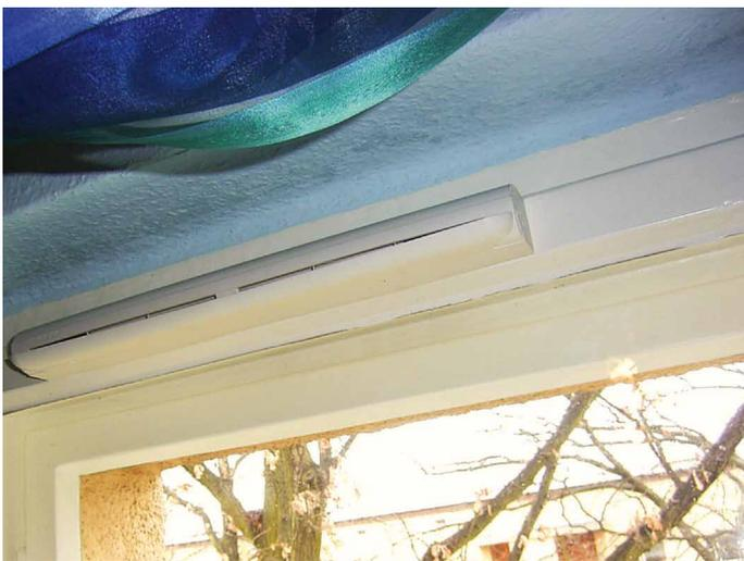
Abb. 2: Raumklimatisch bedingter Schaden im Sturzbereich oberhalb eines Außenluftdurchlasses infolge unterlassenen Betriebs des im Brüstungsbereich vorhandenen Heizkörpers
